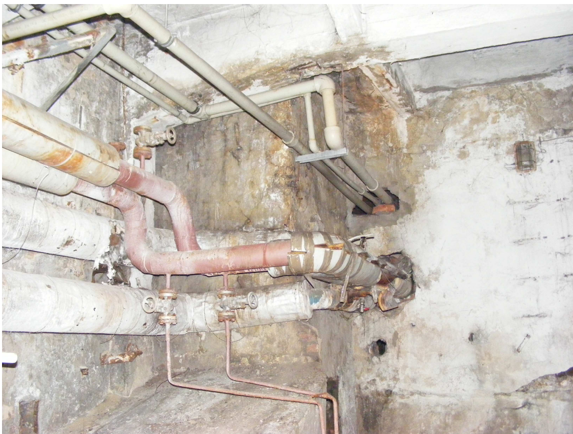
Widok cz. podziemnej komina
