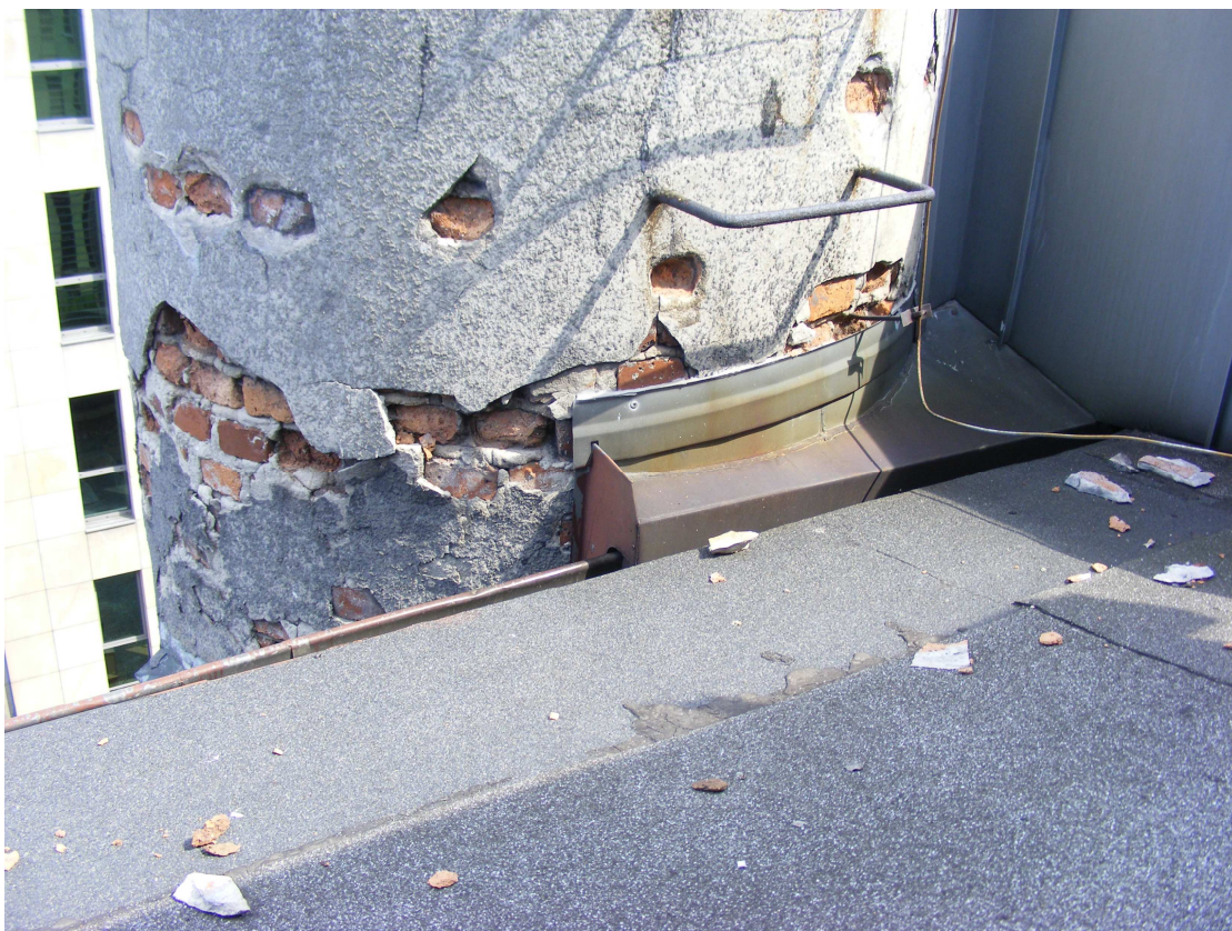
Widok komina przy dachu nad VII piętrem
